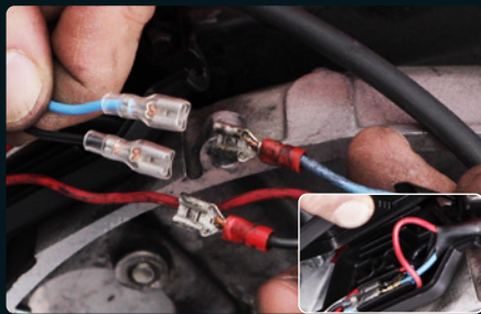
04: Kabelstecker prüfen ggf. Stecker aus dem Lieferumfang montieren. Auf richtige Kabelfarbe achten. [SIP Art.-Nr. siehe Seiten 18 & 19]
